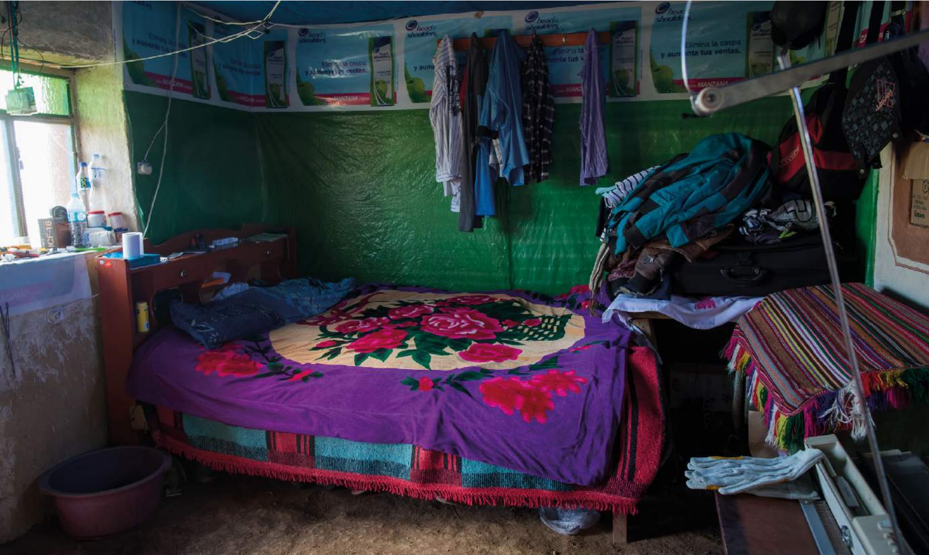
Arriba: El recubrimiento de las paredes, techo y suelo de las habitaciones impiden que la humedad y el viento ingresen a la vivienda. Además mejoran la temperatura interior. Abajo: El comedor, junto a la cocina, es el principal espacio de intercambio familiar donde se reúnen todos sus miembros al comienzo y al final del día.
